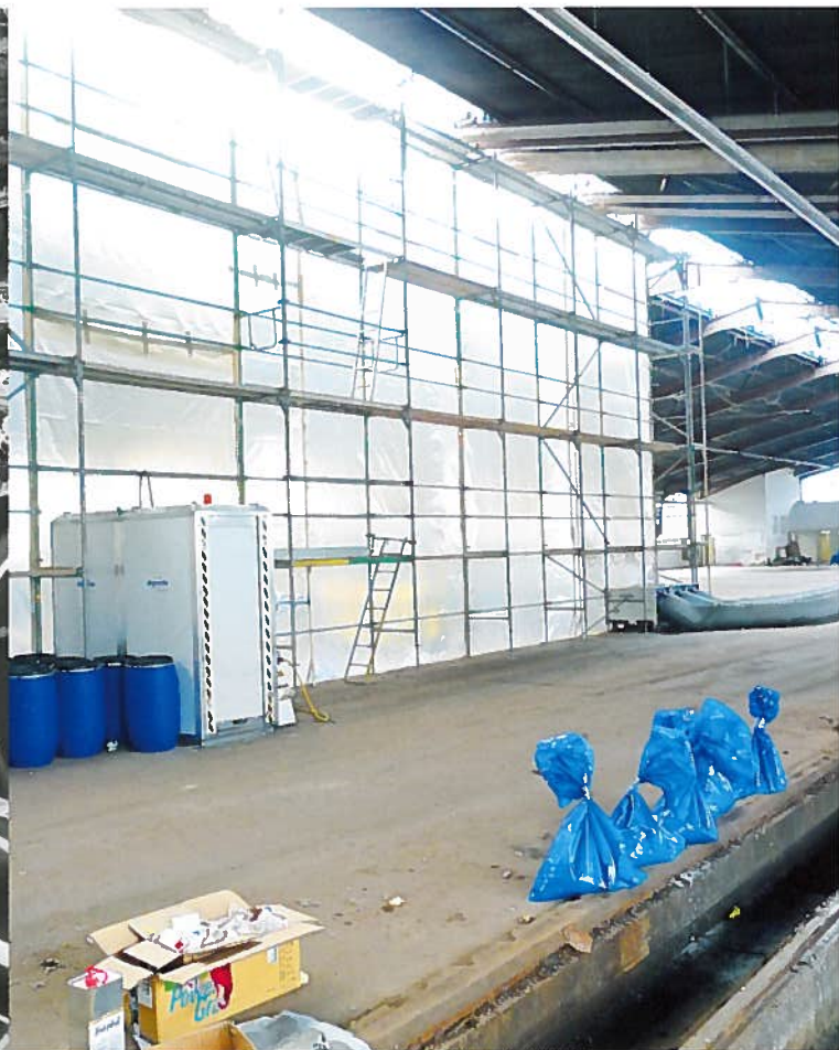
Abgeschotteter Schwarzbereich einer Asbest-Sanierung
