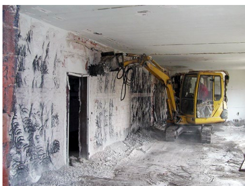
Links: Entfernen von Wandputz mit der Handfräse
