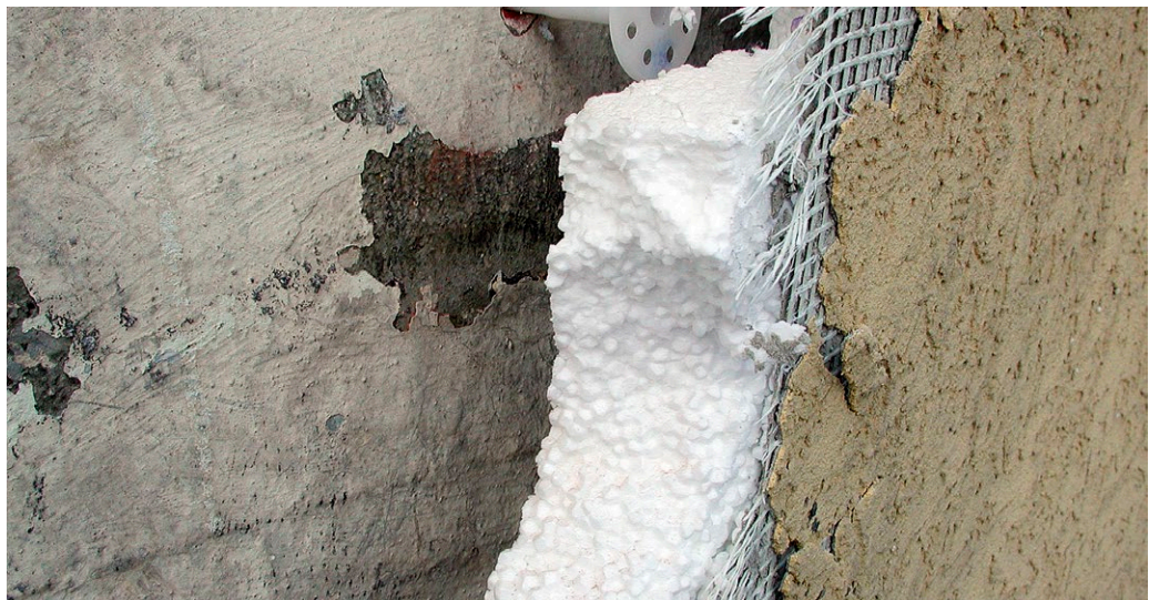
Polystyrol-Dämmstoff in einem Wärmedämmverbundsystem
