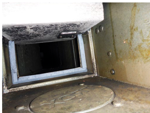
Links: Entlüftungsschacht mit Asbestzement
