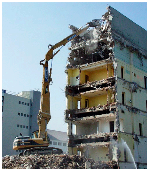
Kontrollierter Rückbau eines Verwaltungsgebäudes
