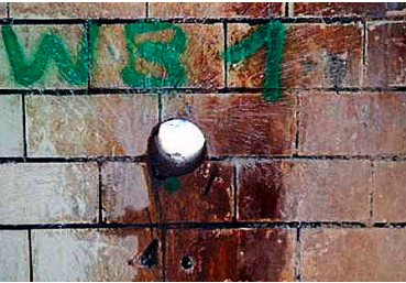
Kernbohrung im Rahmen einer Erkundung
