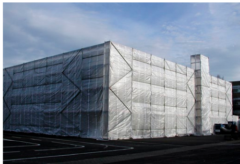
Rechts: Abschottung für eine Asbestsanierung
