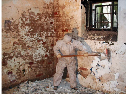
Rechts: Freigelegtes Mauerwerk nach Abstemmen des Putzes
