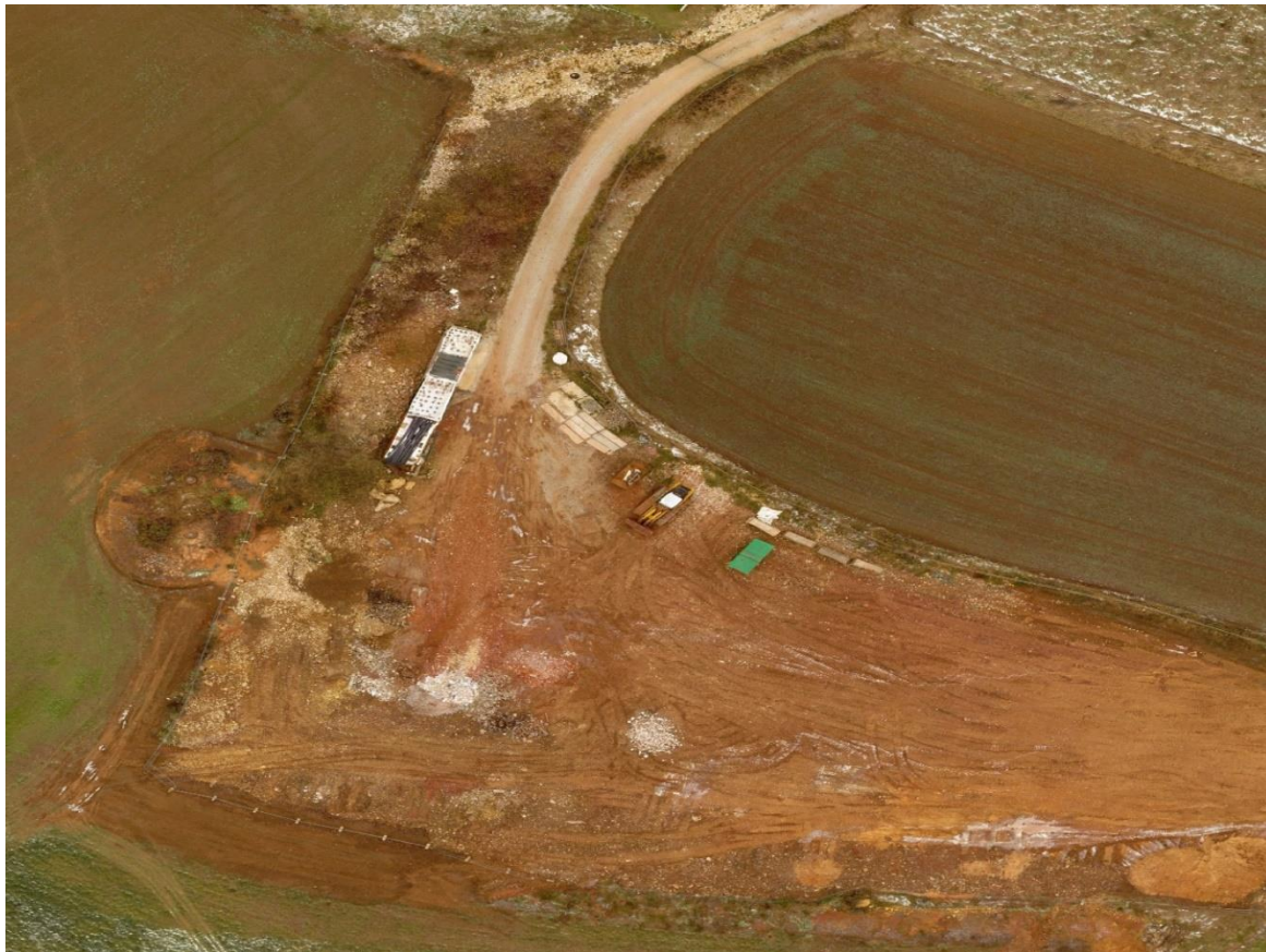
Luftbildaufnahme zur Dokumentation einer Grubenverfüllung
