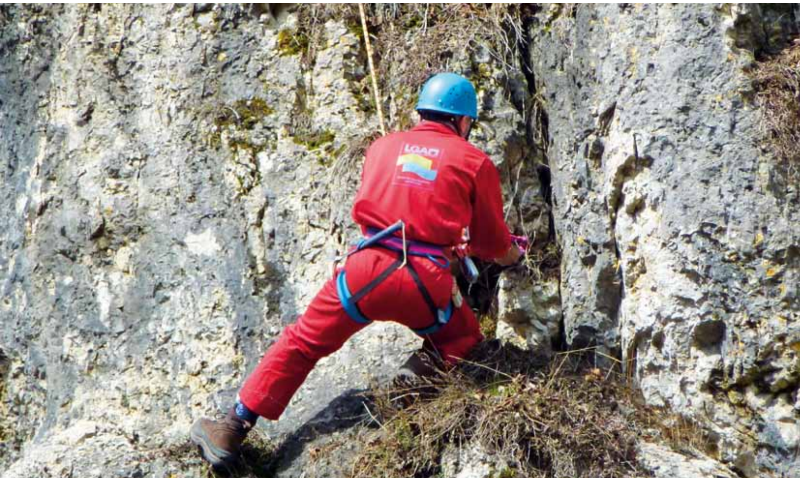
Der Geologe der LGA Institut für Umweltgeologie und Altlasten GmbH begutachtet eine Felswand am Seil.
