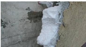
Abb. 3-65: Polystyrol- Dämmstoff in einem Wärmedämmverbu- ndsystem
