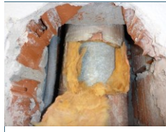
Abb. 4-5-230 Lüftungsrohr aus Asbestzement mit KMF-Isolierung
