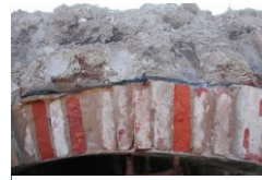
Abb. 4-5-10: Aufgeklebte Sperrbahn auf einem Gewölbe
