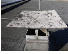
Abb. 4-5-215: Entlüftungsschacht mit Asbestzement
