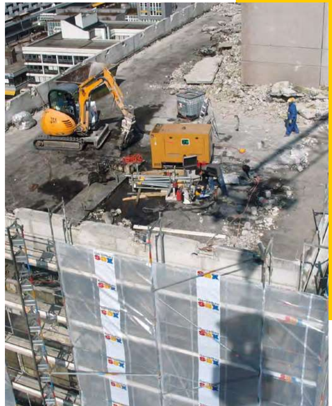
Kleinteiliger Abbruch oben und großes Gerät unten beim Hochhausrückbau
